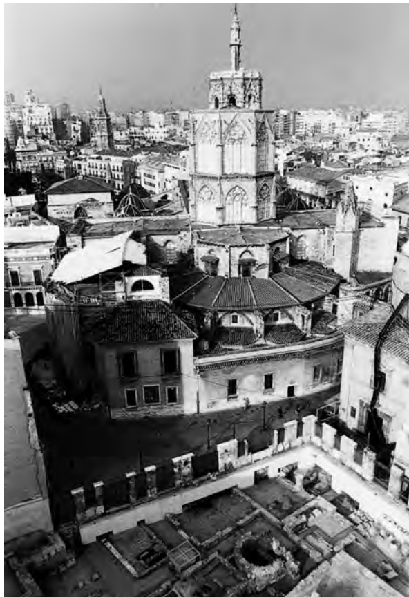
Figura 1. La plaça i les excavacions de l'Almoïna amb la seu al fons.
